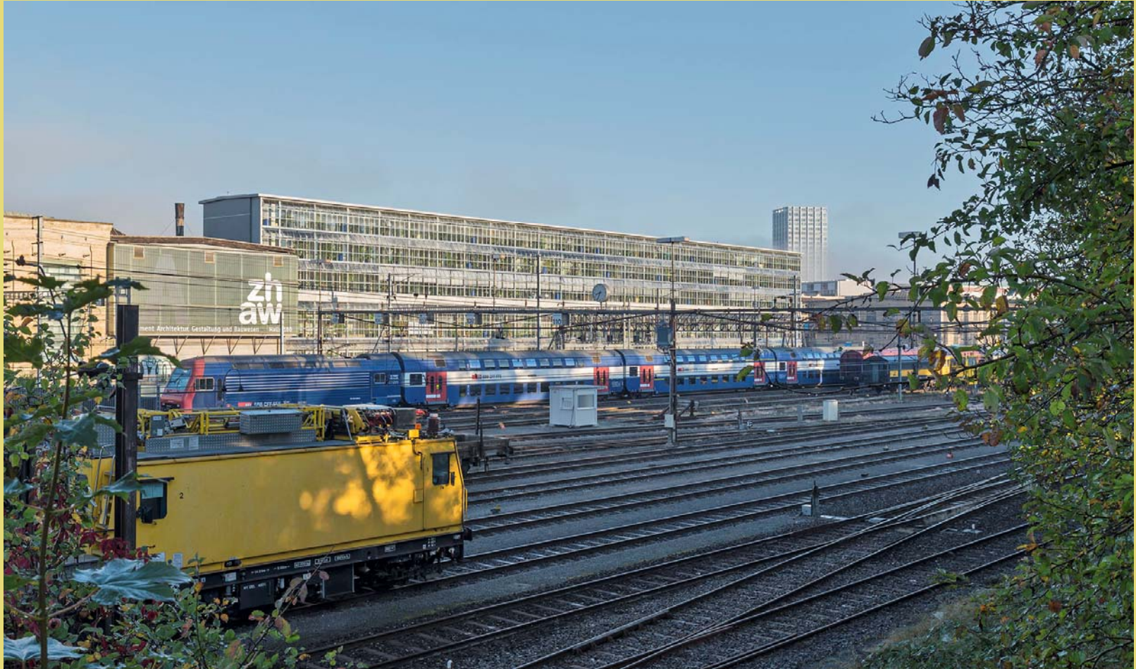
Umbau + Aufstockung Halle 181, Winterthur, Kilga Popp Architekten «Goldener Hase»
