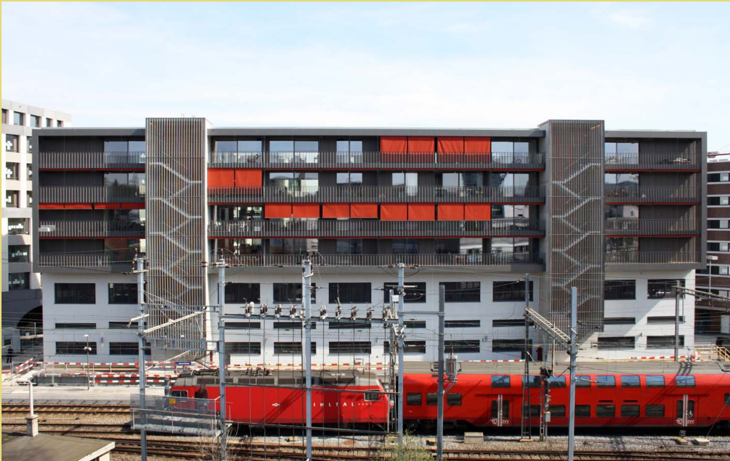
Aufstockung SZU Betriebsgebäude 2013 Burkhalter Sumi Architekten
