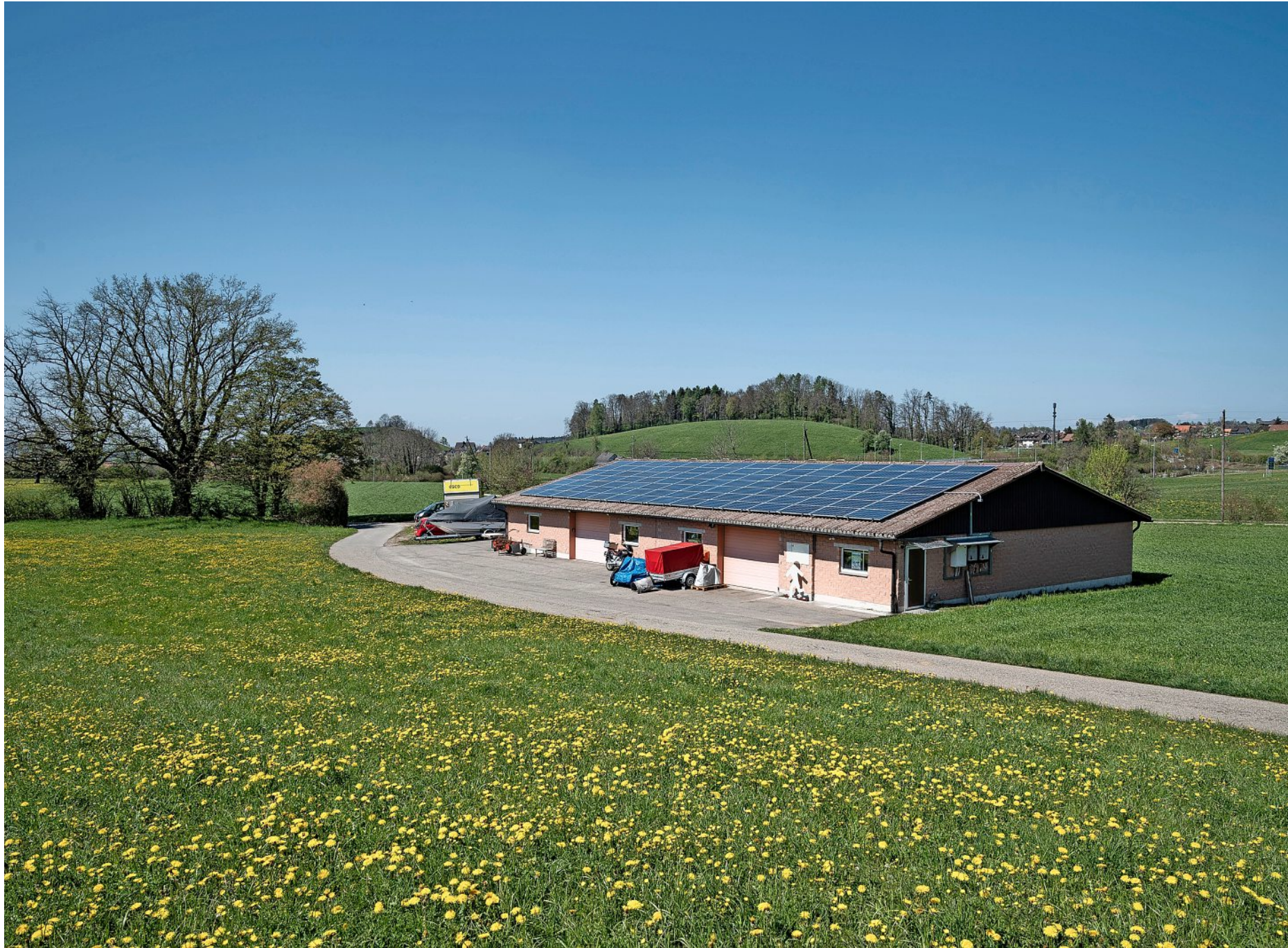
So gross wie ein Tennisplatz: Die Solaranlage auf dem Dach der ehemaligen Schweinemästerei in Unterottikon. Foto: Andrea Zahler
