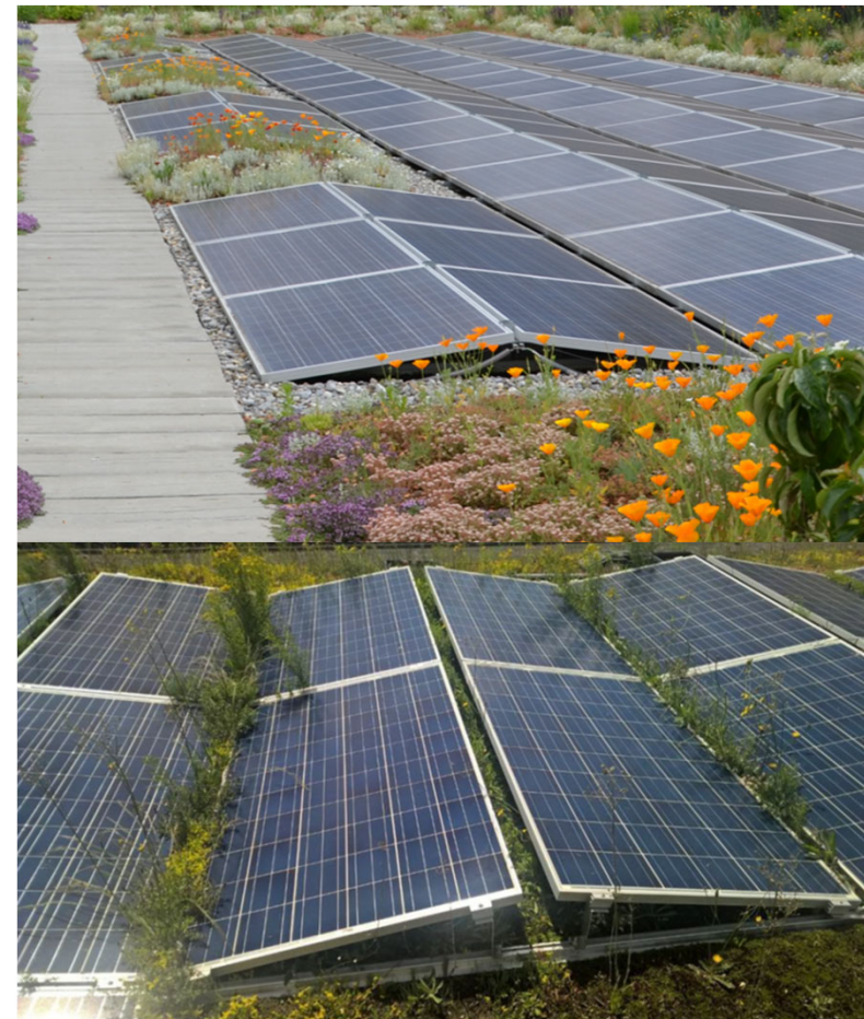
Bild: ZHAW PV Dachanlage ohne räumliche Trennung
