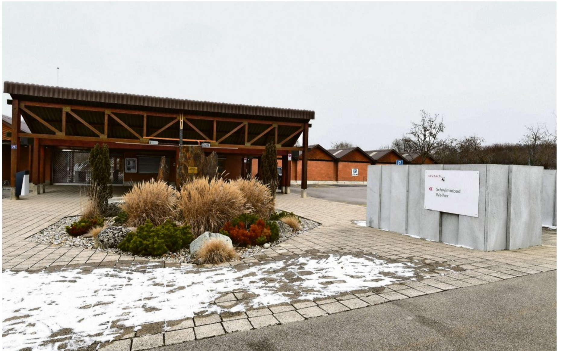
Auf dem Dach des Schwimmbads Weiher in Seuzach könnte eine Solaranlage 50 Prozent des Stromverbrauchs der Badi produzieren.
