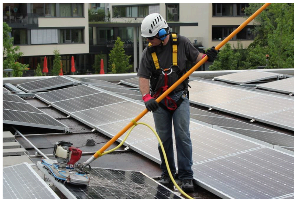
Hexapro mit Schlauch ½“ montiert an Strato-Rohre
