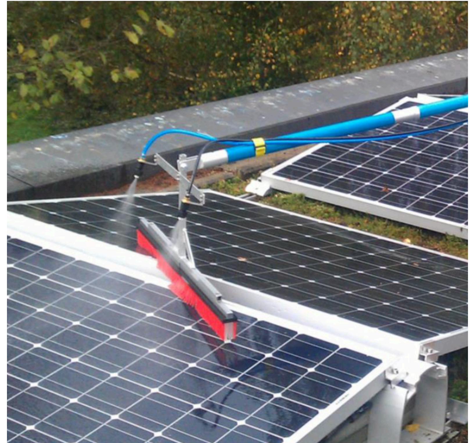
Solarreinigungsbürste im Einsatz
