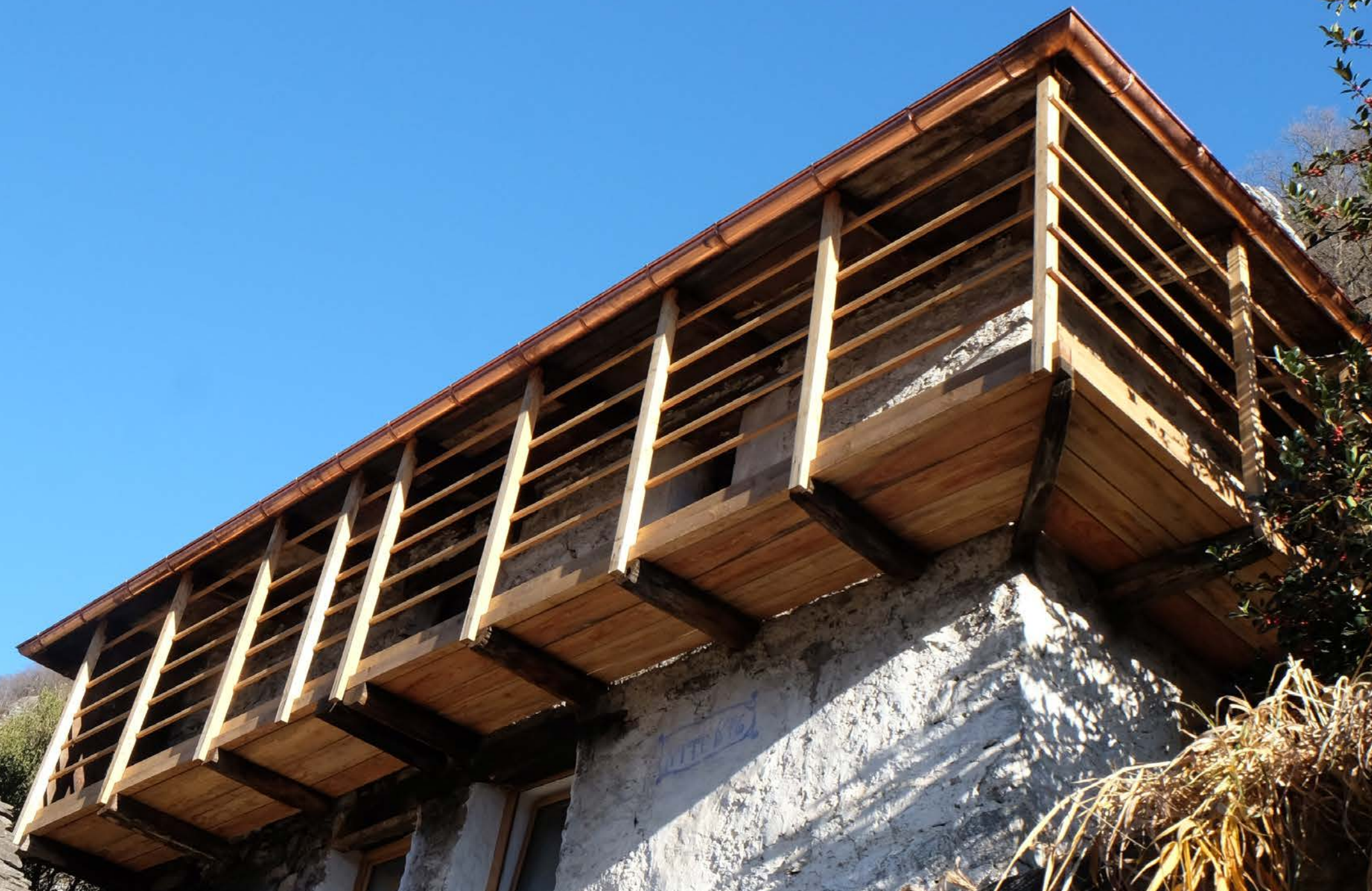
Historisches Tessinerhaus 18. Jh. Cheminéeheizung mit Speicher und therm. Kollektoren
